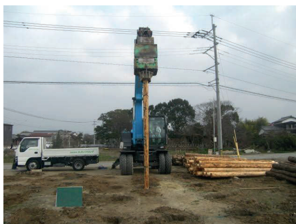
写真-2 丸太打設による軟弱地盤対策実施状況(写真提供: (株)九州パイリング、QP パイル工法)
