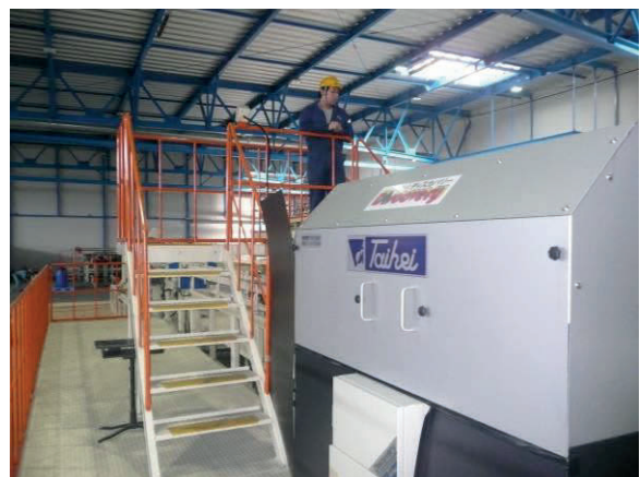
▲ 記念すべき0号機改の設置
